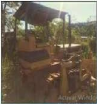
Fotografía 1. Bulldozer utilizado para la remoción de capa vegetal y conformación de los terrenos.
